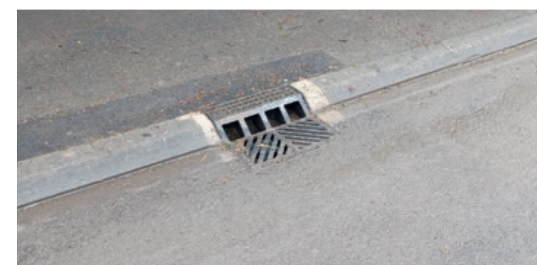
Création d'un avaloir pluvial chemin de Loutremange
