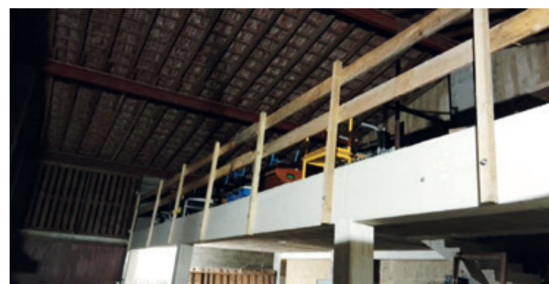
Sécurisation de la dalle dans l'atelier communal
